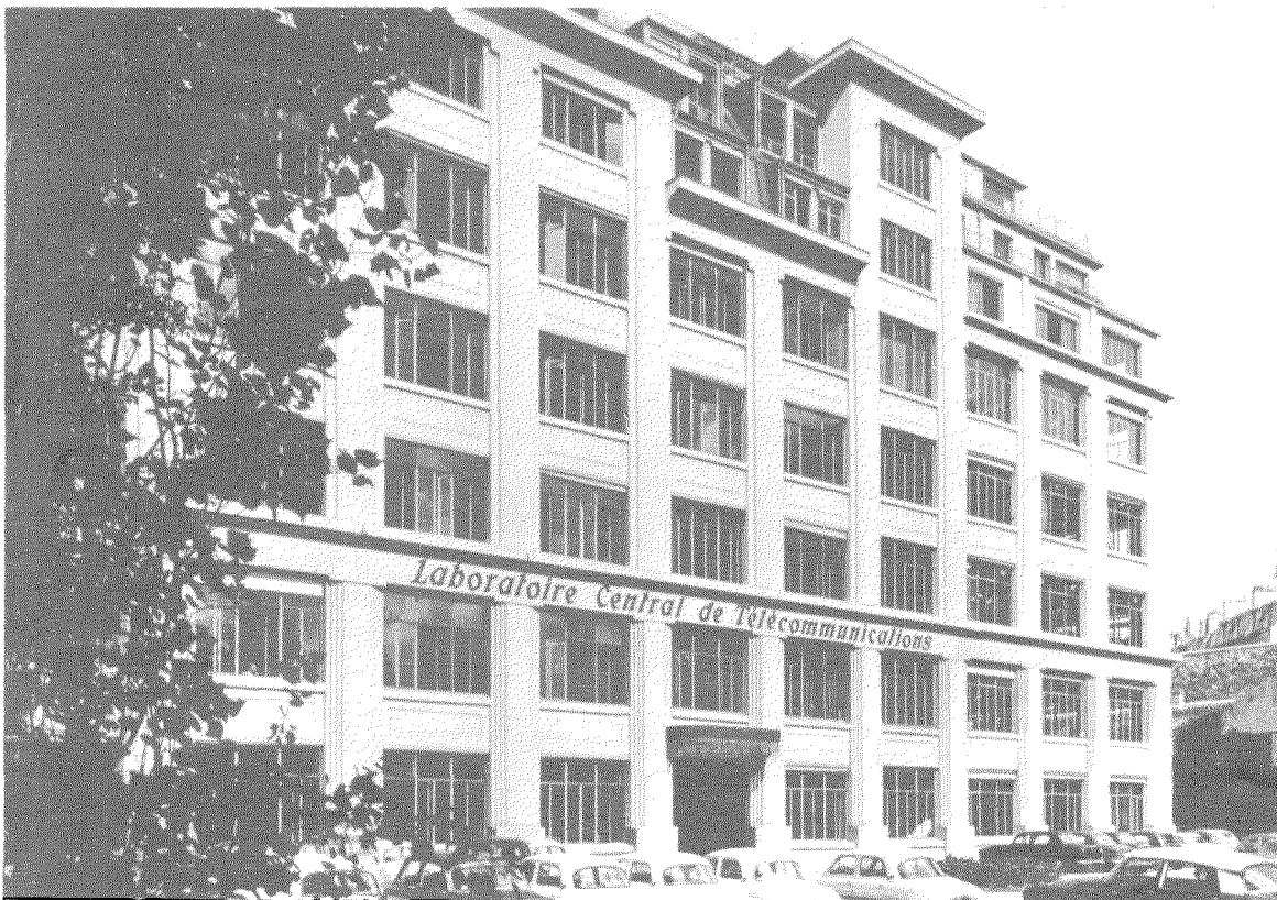
Figure 1—East front of Laboratoire Central de Télécommunications.
